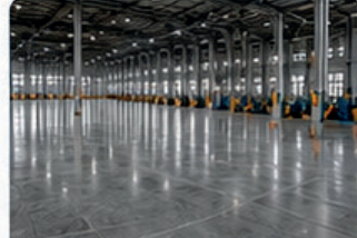
FABRİKA SAHA BETONU
