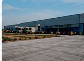
YOL & ZEMİN BETONU
